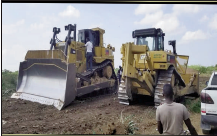
Équipements lourds mis en oeuvre dans la construction d'une route reliant l'intérieur à Port Dauphin.
